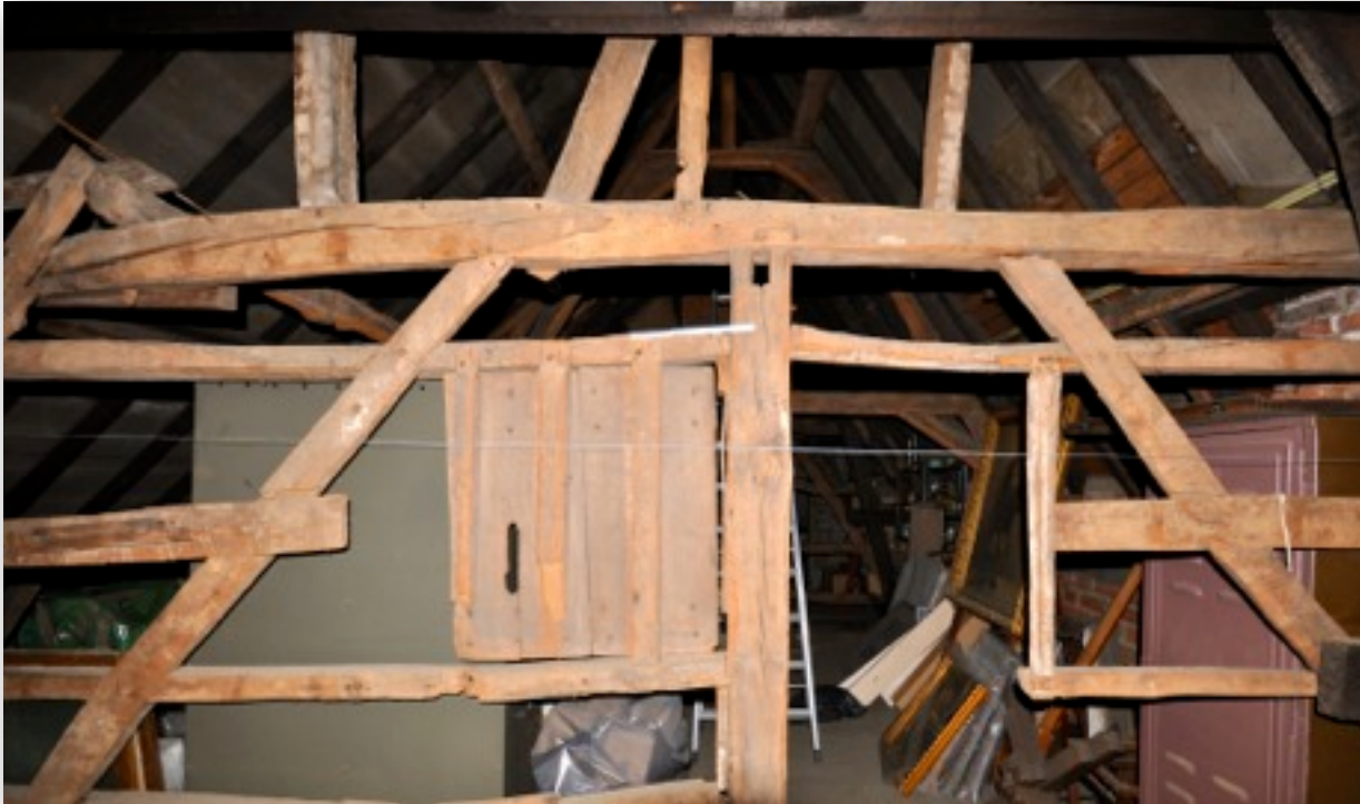
Foto 3. Begijnhof van Anderlecht, Kapelaanstraat 6. Dakconstructie van het westelijk gebouw van het complex dat in de XVII e eeuw werd gebouwd in baksteen. Op de voorgrond dakgebinte nr. 2, dat gebruikmaakt van de oude houten constructie van de voorgevel van een middeleeuws gebouw in vakwerk dat misschien van de XIII e -XIV e eeuw dateert (© Paulo Charruadas en Philippe Sosnowska, Centre de Recherche en Archéologie et Patrimoine, Université Libre de Bruxelles, 2010).
